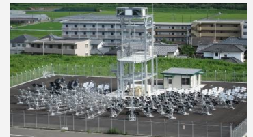
図1 ビームダウン式太陽集光装置
