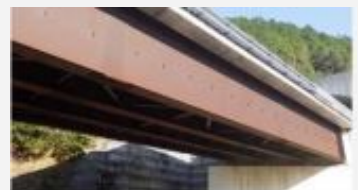
図3 宮崎県内の耐候性鋼橋梁
