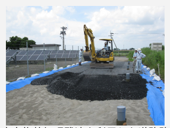
廃棄物熱処理残渣を利用した道路路盤材施工実験
